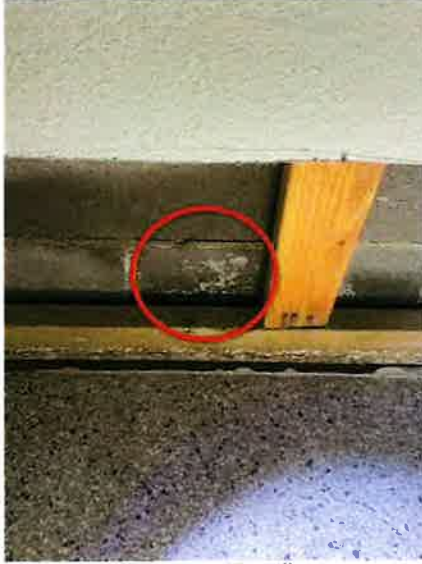
Garage SE wall
